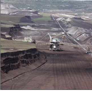
Mina de lignitos en Alemania Lignito
