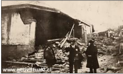
Daños del terremoto de 1922 en Freirina, Región de Atacama véase más de Atacama
