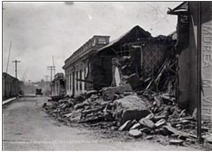
Daños del terremoto de Copiapó en 1918. (Museo Regional) véase más de Atacama
